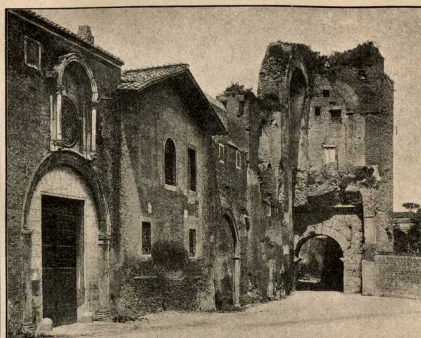
6. Bogen des Dolabella und Silanus, 10 n. Chr. aus Travertin errichtet, von Nero als Träger seiner Wasserleitung benutzt. Nach Photographie.
