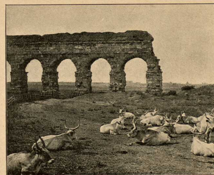
30. Wasserleitungsbogen in der Campagna di Roma. Nach Photographie.
