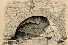
13. Mündung der Cloaca Maxima in den Tiber (mit dem vorgelagerten späteren Steuergang). Nach Levy-Luckenbach, Das Forum Romanum S. 6 Fig. 2.
