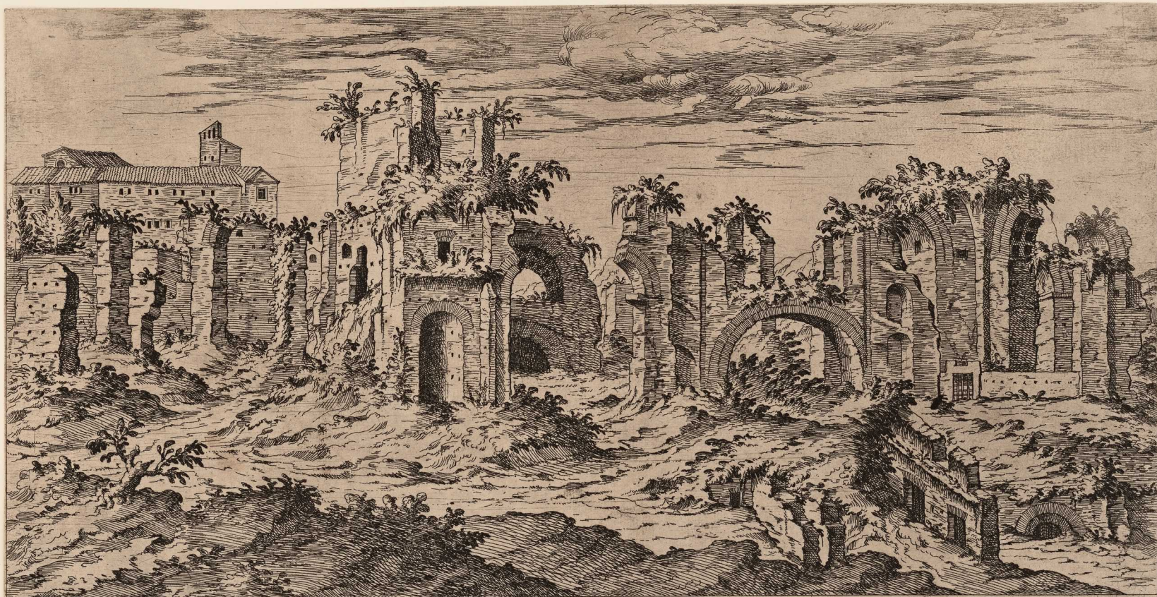
Vestigi delle Terme di Tito dalla parte che riguardano il Mezzogiorno et sirocco donde e' il monte celio, quali furono edificate nelle carina sopra parte della casa aurea di Nerone, nella qual ruina casandari al tempo di papa Pio V. u' furono trovate colonne base, et capitelli di marmo bellissimo l'ordine composito et molti altri frammenti.
