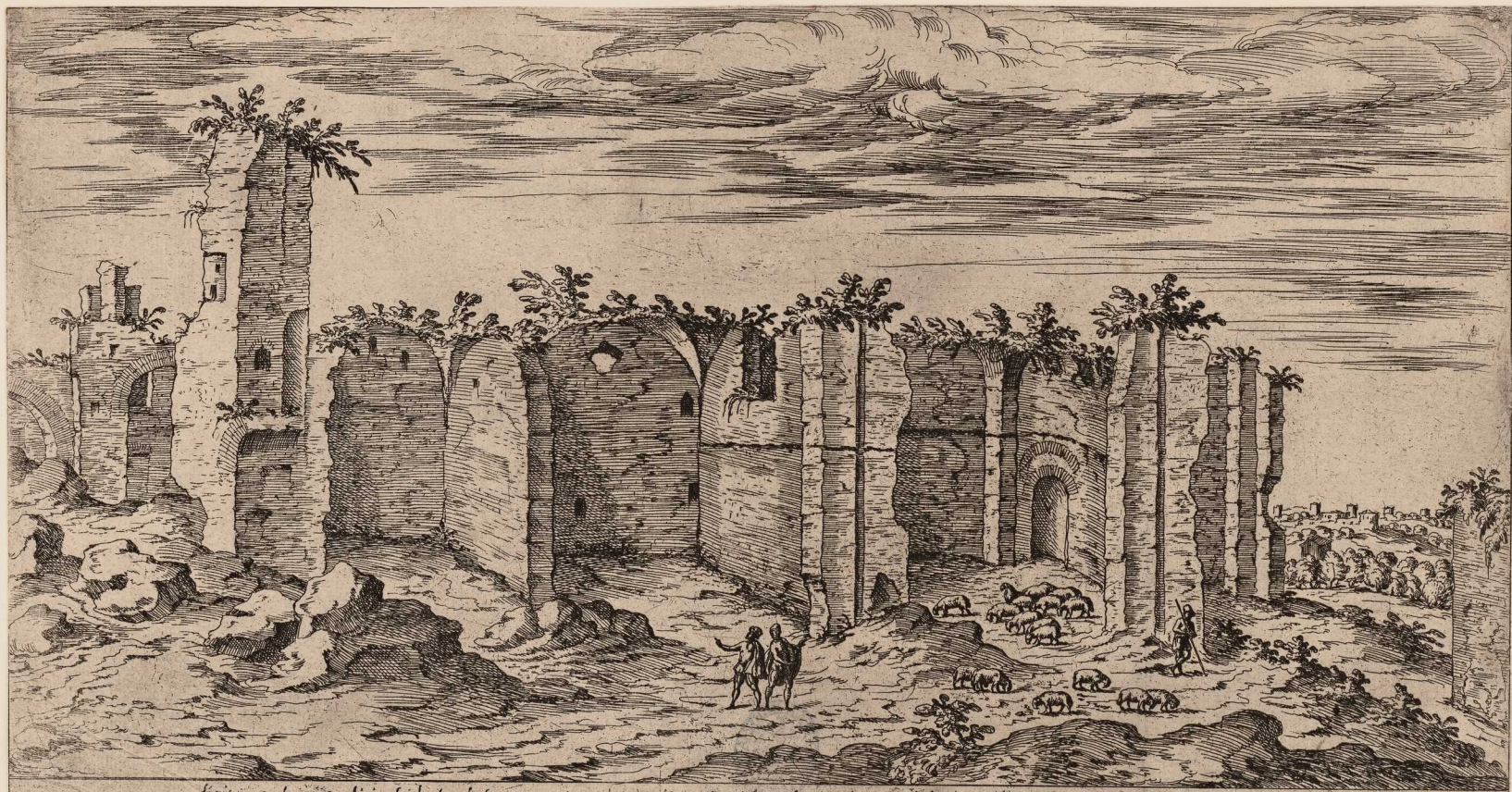
di pitura, scultura, stucchi e mosaica le volte furono murate con pietre pomice per esser piu lege et dare maggior peso a ledificio, oggidi questo luoco e' spogliato di tutti gli adornamenti sopradetti et non vi si uede altro che mura di mattoni che danno notizia della grandezza e bellezza di esso il uulgo lo chiama oggidi l'Antoniana
