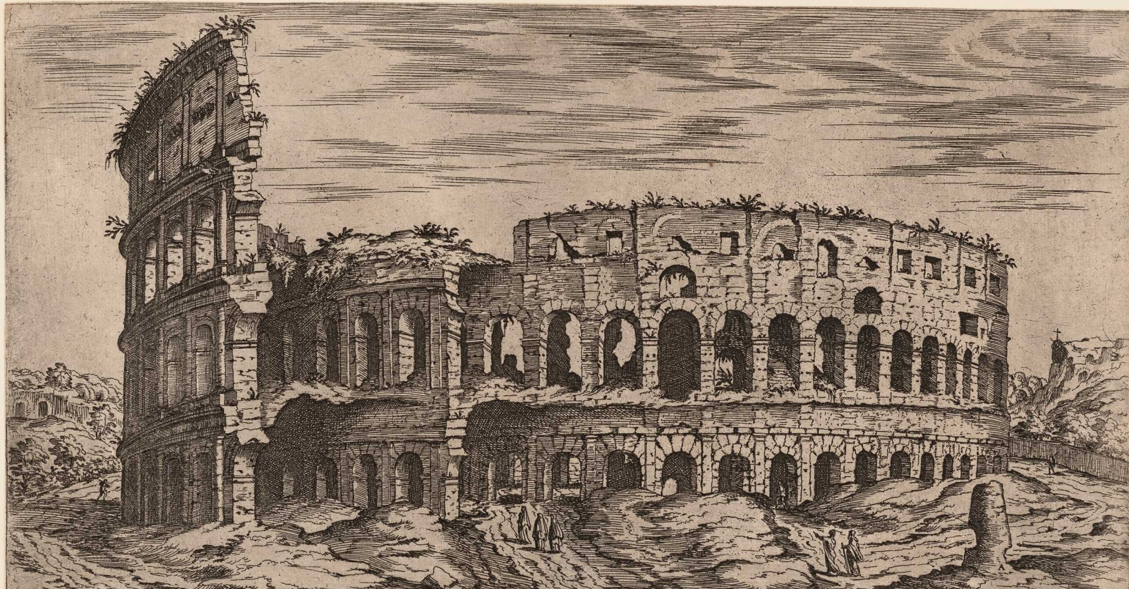
Vestigi della parte di fuori dell' Anfiteatro di Tito, qual fu primo edificato da Vespasiano suo padre poi da lui dedicato. Fu questo edificio di pietra d'erauertino, e di forma ovale, ornato con pilastri e colonne di mezzo stile, d'opera dorica, ionica, e corinthia. Hoggi si uode gran parte rouinato, et si chiama volgarmente il Colosseo, al segno. A. tra la Meta sudanie cosi chiamata da gli Antichi perche da lei usciva una fontana con gran copia d'acqua
